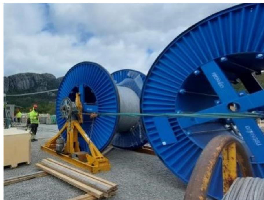
**Foto:** le bobine utilizzate hanno un diametro di 3.750 mm e hanno richiesto speciali camion ribassati per il trasporto eccezionale.
